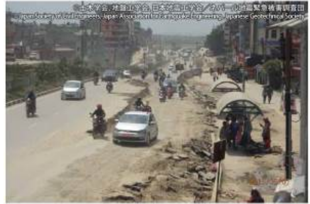
(左) 前図の干渉画像のうちカトマンズ市街を拡大したもの。局所的な変位が見られる。(右) 土木学会・地盤工学会・日本地震工学会のネパール地震緊急被害調査団により撮影されたネパール市街で特に地盤の変動が大きい箇所。左図の局所変位のうち右下部に対応する。
